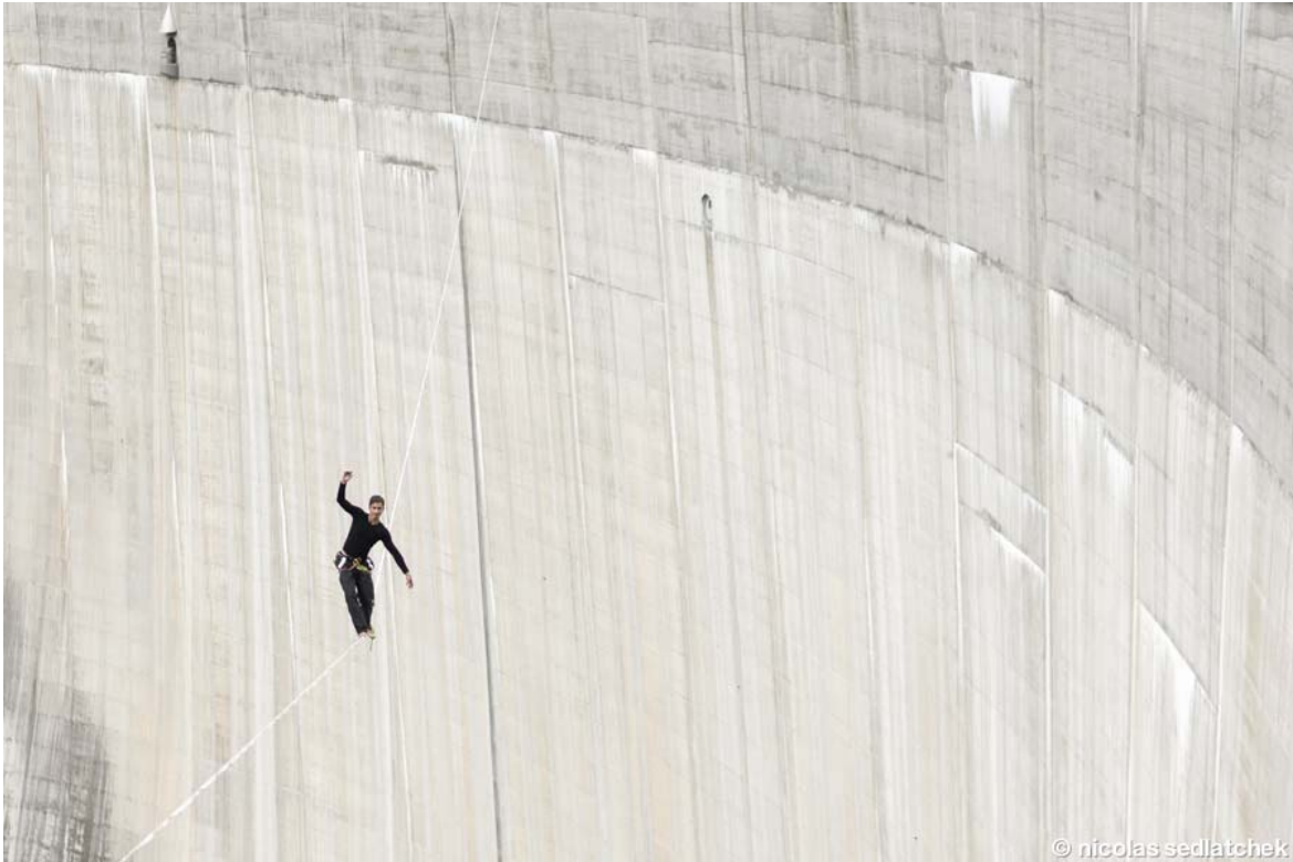
Abb. 3: Julian Mittermeier parallèle au barrage de Mauvoisin, Val de Bagnes, Switzerland
